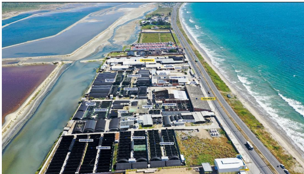
Figura 2. Vista aérea del Laboratorio
