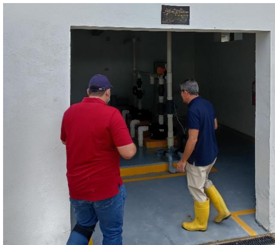
Figura 4. Captación y Conducción de Agua de Mar
