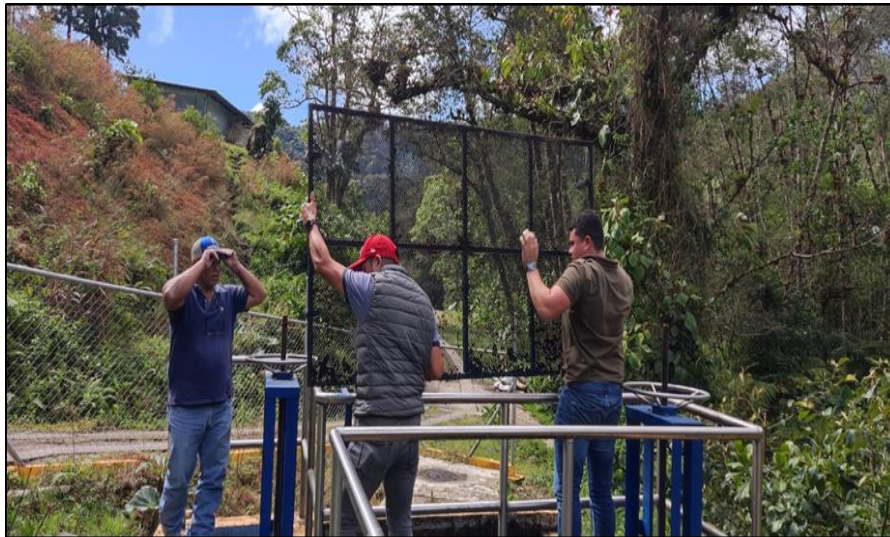
Limpieza del Desarenador y Malla de Aducción-Obra de Toma Alto Bambito
