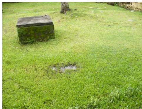
Vista parcial del sistema actual de tratamiento de aguas residuales del Puesto Cuarentenario en Paso Canoas, provincia de Chiriquí.
