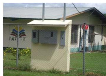
Oficinas de Agencias Agrícolas en Los Santos, completamente rehabilitadas.
