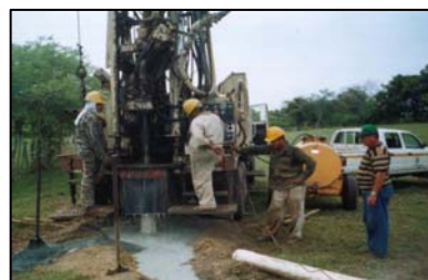
Perforación de pozos en la provincia de Veraguas
