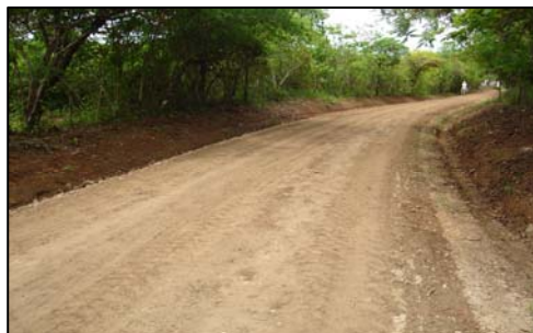
Rehabilitación de caminos, provincia de Veraguas.
