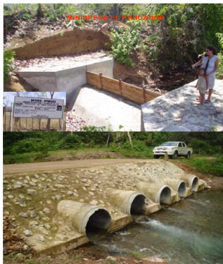
Construcción de represas en las provincias de Herrera y Los Santos.
