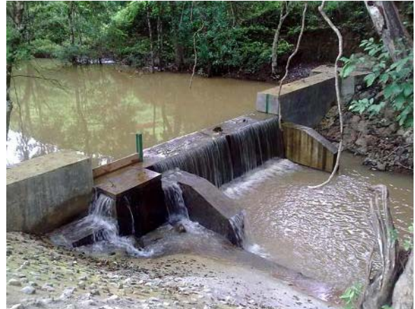
Proyecto Riego faldar, distrito de Macaracas, provincia de Los Santos.
