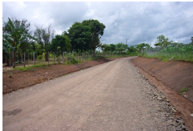
Rehabilitación de caminos, provincias de Bocas del Toro y Chiriquí
