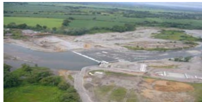
Vista Aérea del proyecto donde se capta el agua del Río Chico. A la derecha canal principal que es un conducto de 3.3 Km de longitud, mediante el cual se distribuye el agua a los canales secundarios.
