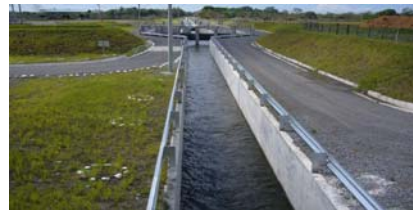
Vista Aérea del proyecto donde se capta el agua del Río Chico. A la derecha canal principal que es un conducto de 3.3 Km de longitud, mediante el cual se distribuye el agua a los canales secundarios.
