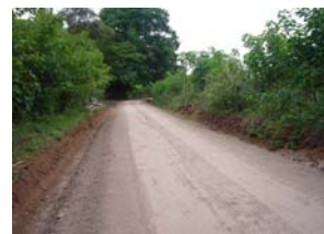
Rehabilitación del Tramo de Camino de Producción de La Espigadilla – Los Santos. Longitud de 3.8 km.
