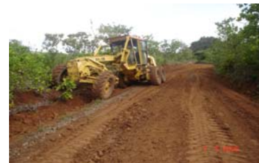
Construcción del tramo de camino El Bale de Nurúm, con equipo del MIDA
