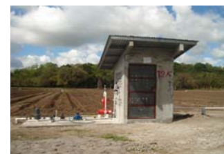
Sistema de Riego instalado en finca de Productores de la prov. de Chiriquí.
