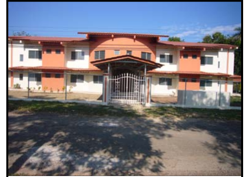
Vista del edificio de Internado de varones, con capacidad para alojar a 200 estudiantes, cuyo costo es de B/.944,136.93.
