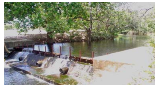
Represa de mampostería, ubicada en el distrito de Los Pozos, provincia de Herrera.
