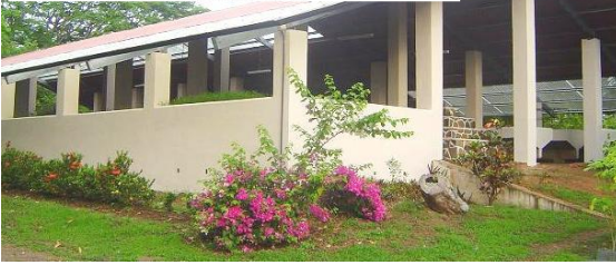
Instituto Nacional de Agricultura Rehabilitación de Infraestructuras de vivero para la producción de plantas maderables, Ornamentales y frutales por un monto de B/ 38,720.48.
