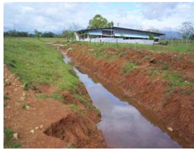
Canales de Drenaje construidos en estación Acuícola de Gualaca año 2006.
