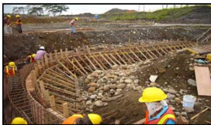
Construcción de muro de cierre para protección de estructuras hidráulicas en riberas del río.
