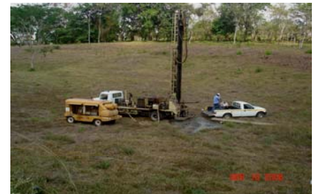
Perforación de pozos
