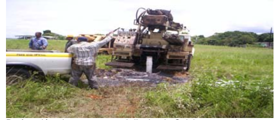
Perforación de un pozo en el distrito de Calobre para abastecer de agua un invernadero destinado a la producción de plántones para productores de rubros de exportación.
