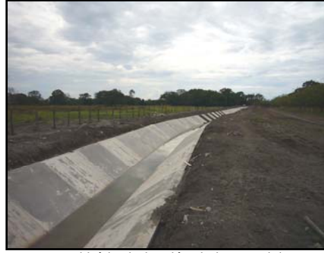
Izquierda: Obra de captación sobre el río Chico que permitirá la derivación de los caudales requeridos por el sistema. Derecha: Tramo de canal de conducción revestido para conducir un caudal de 5.00 m 3 /s a las áreas de riego.
