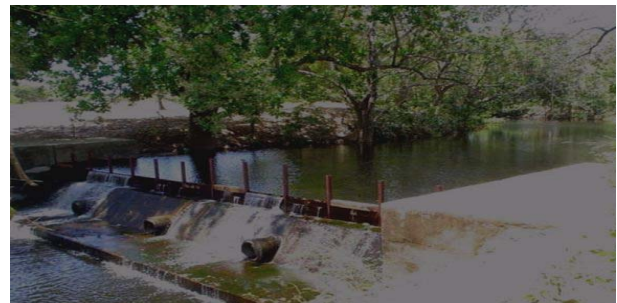
Represamiento con compuertas desmontables Aguas arriba en Herrera
