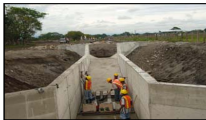
Construcción de muro de cierre para protección de estructuras hidráulicas en riberas del río.
