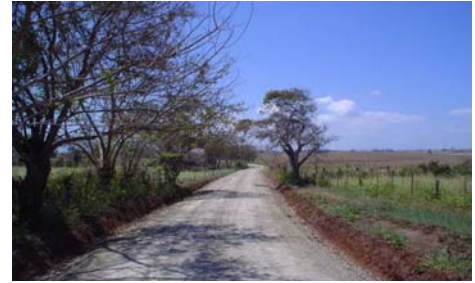
Camino rehabilitado en las comunidades de Pocrí-Aranda, provincia de Los Santos, con una longitud de 5.13 Km., beneficiando aproximadamente a 50 productores del área.
